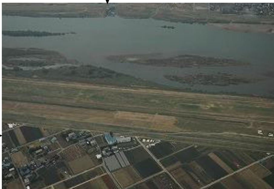
めぬま 妻沼訓練所の格納庫棟
